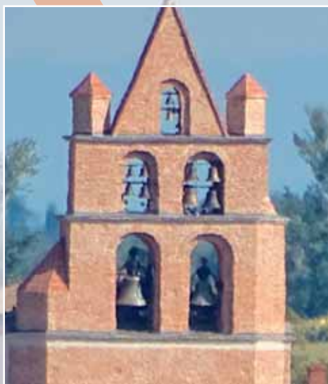
Vue de Montjoire, l'église de Paulhac.
