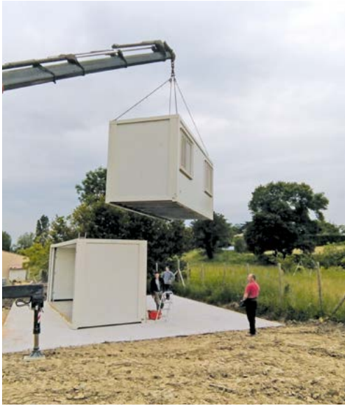
Pose des algécos après la construction en régie de la plate-forme technique par les agents techniques, les élus et les chasseurs bénévoles : un beau travail d'équipe !
