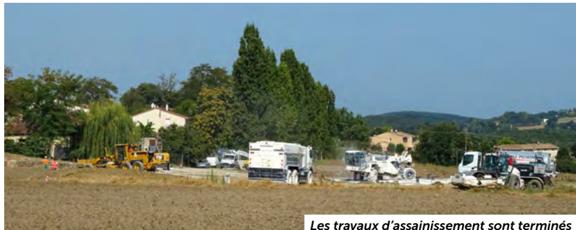
Les travaux d'assainissement sont terminés
