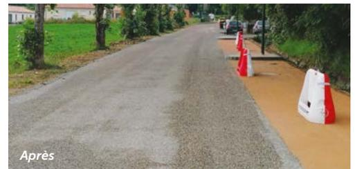
C'est un revêtement plus naturel que le goudron qui a été utilisé pour les places de parking. Le mélange composé de sable, de gravillons et de ciment, de couleur ocre, offre une légère perméabilité. Il est recommandé pour les voies à faible circulation ou les places de stationnement.
