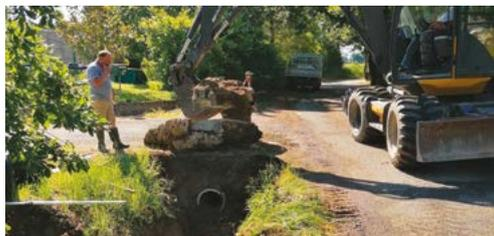
Afin d'éviter des dégradations sur la chaussée et un risque d'affaissement, le fossé a été busé.
