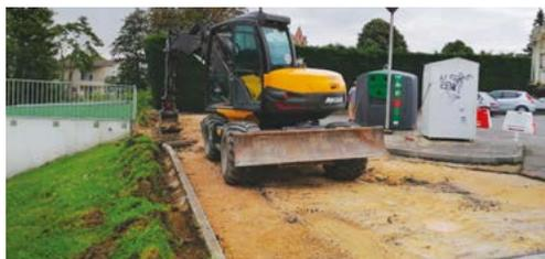
La dégradation et un léger affaissement, devant la chaufferie bois, du bitume du parking de la salle des fêtes a nécessité une reprise du revêtement sur un quart de la surface totale.
